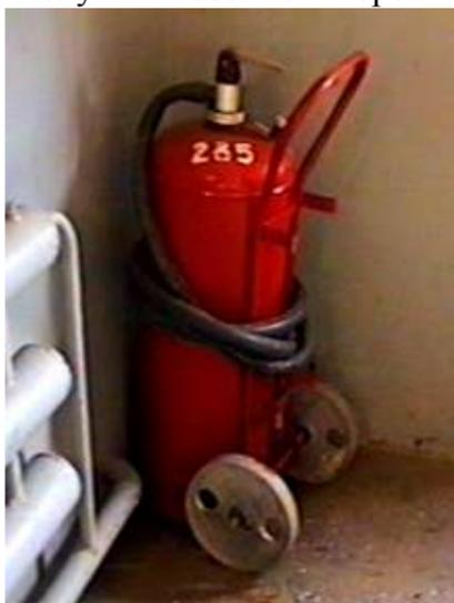
**Порошковые огнетушители (ОП)** предназначены для тушения пожаров твердых, жидких и газообразных веществ (в зависимости от марки используемого огнетушащего порошка), а также электроустановок, находящихся под напряжением до 1 кВ (1000 В). Принцип работы передвижного огнетушителя ОП-50(З) основан на вытеснении огнетушащего порошка (при открытом клапане запорного устройства) сжатым воздухом, находящимся в емкости. Для приведения огнетушителя в действие необходимо выполнить следующее:
